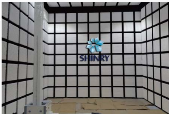
三米法电波暗室
